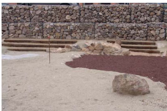
Gaviones instalados y acondicionamiento posterior del entorno
