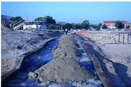
Trabajos preliminares e itinerario finalizado
