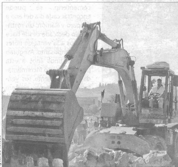
En los viales se introducirá nuevo alumbrado y arbolado.
