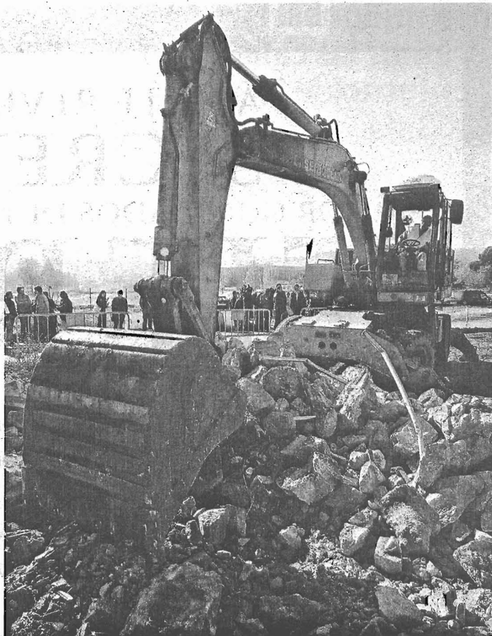
Ayer comenzaron las obras con el derribo del muro de la Puerta de Obreros
